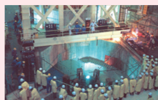
1988年 原子炉改造工事
